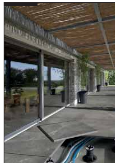
POSA SOPRAELEVATA E DRENANTE pag. 92
